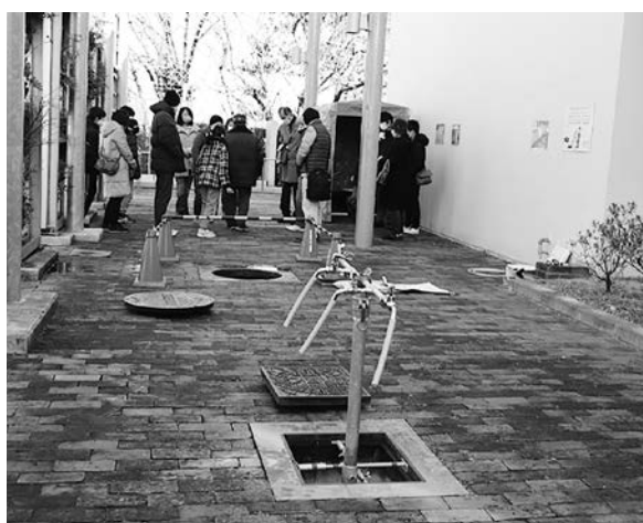
1月8日 屋外で、災害用トイレ、地下式給水栓、仮設給水栓の実物を見学しました。
