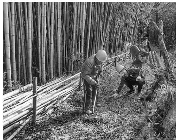
粉碎したウッドチップを敷き均している（1月15日、猪高緑地）
